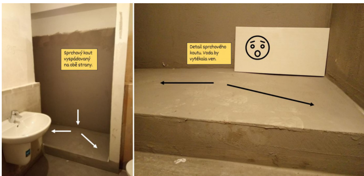
Nebezpečná elektroinstalace od developera (foto: Hedvika Novotná)
